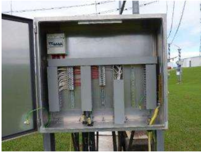
(d) =D15-A92 Bay DC Marshalling Kiosk
